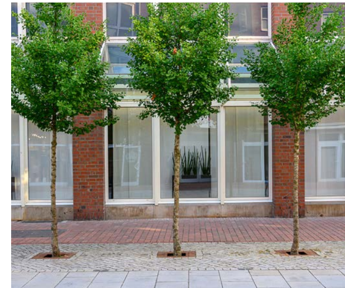
Wasserdurchlässigkeit der Fugen
