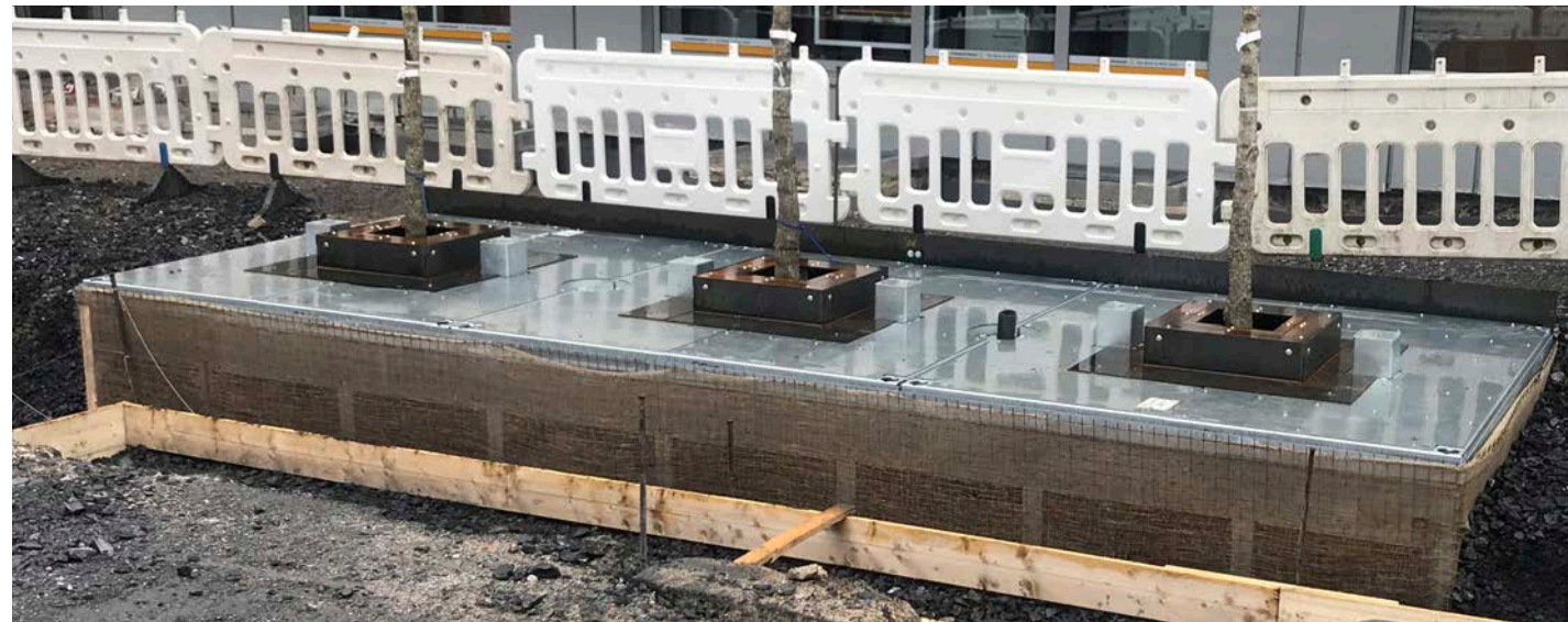
Unterflurbaumrost überpflasterbar mit integriertem Bewässerungssystem (Fa. Humberg)
