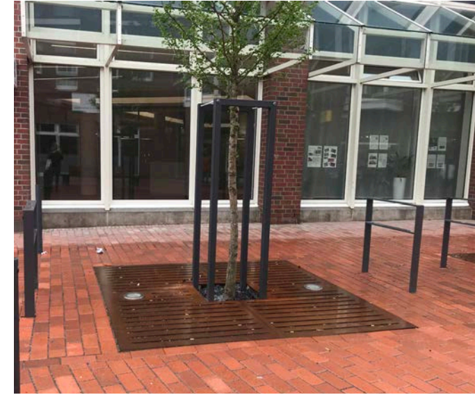
Unterflurbaumrost mit Rostabdeckung aus Cortenstahl (Fa. Humberg)
