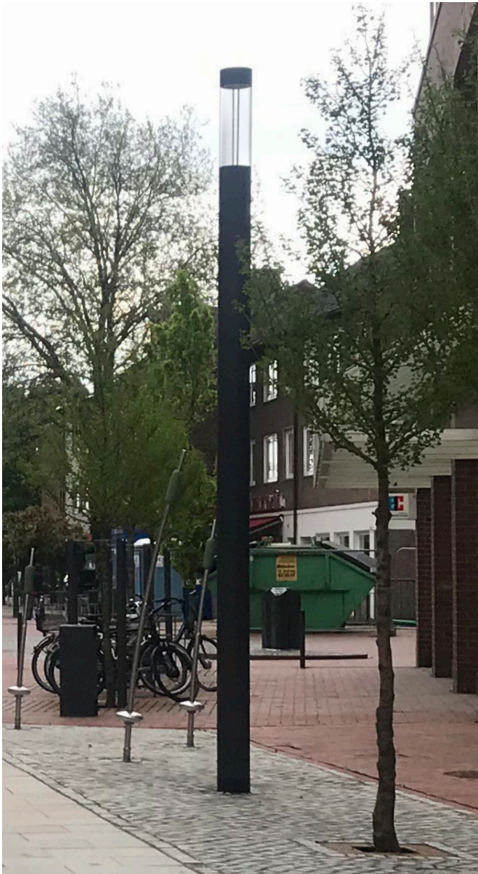
Lichtstele (LED-/Wi-Fi-Lichtbauelemente, Fa. Bega)
