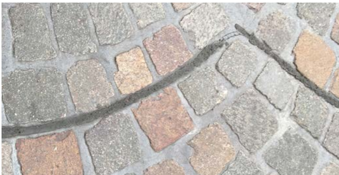
gebundene Bauweise mit Dehnungsfuge
